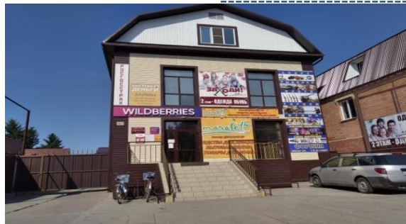
Строительство общественно-делового центра «На Красноармейской»
