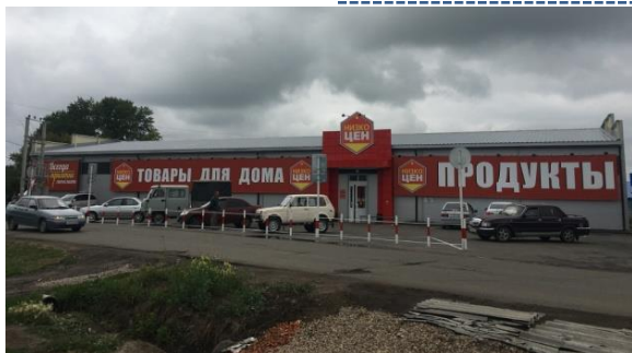
Строительство магазина сети «Низкоцен»
