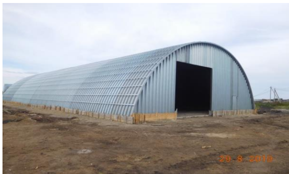
КФХ Боченкова С.В. Строительство бескаркасного ангара для хранения сельскохозяйственной техники. (д. Яготово)
